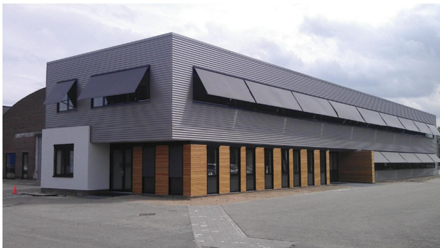
Screens en uitvalschermen aan bedrijfsgebouw
